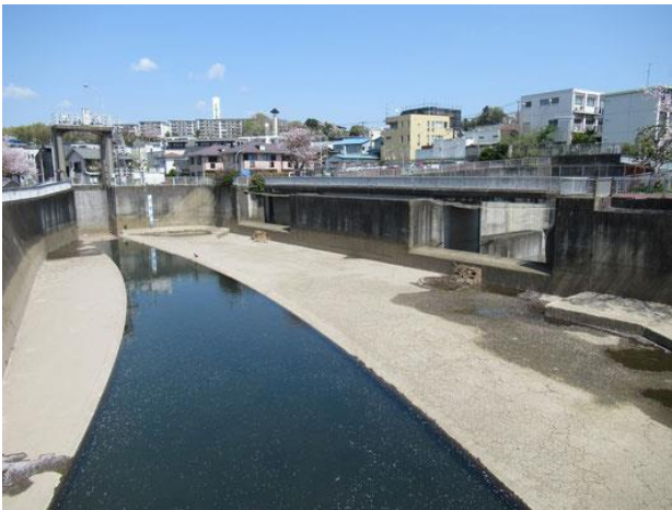
大岡川取水庭です。大雨が降った時、ここから分岐している大岡川分水路に雨水を流して川の氾濫を防いでいます。
